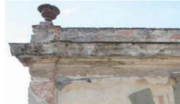
cornice di coronamento di portale modanata realizzata in mattoni laterizi intonacati con muretto d'attico che nasconde la copertura
