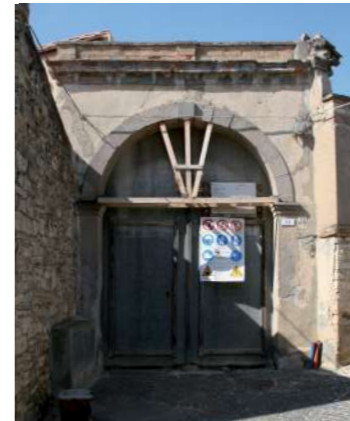
portale ad arco a tutto sesto in conci lapidei squadrati su pulvini e stipiti dello stesso materiale
