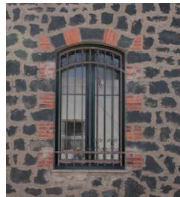
finestra con arco ribassato e stipiti realizzati dall'alternanza di conci di pietra e mattoni laterizi
