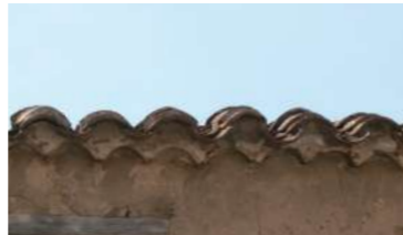
aggetto con cornice realizzata con una fila di tegole convesse e smaltimento diretto della acque
