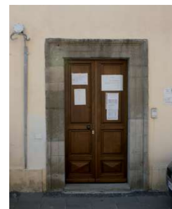
porta di palazzetto con cornice lapidea squadrate e modanate e serramento a due ante
