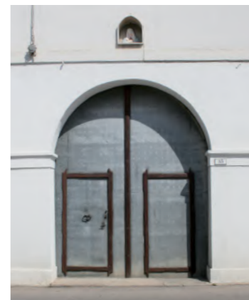
portale ad arco a tutto sesto con serramento ligneo rivestito in lamiera
