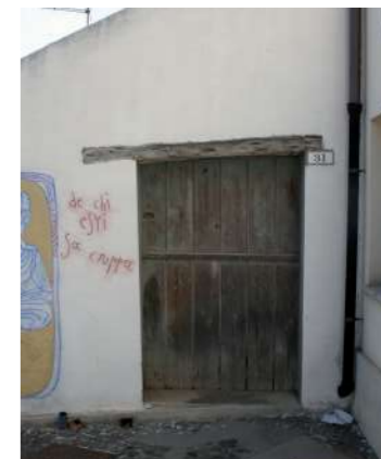
accesso secondario alla corte attraverso il loggiato mediante portoncino con architrave ligneo
