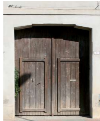
portale recente con serramento ligneo e architrave rastremata in cls armato
