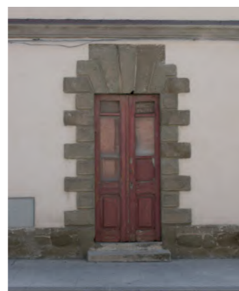
porta con piattabanda e stipiti in pietra squadrate in risalto rispetto alla muratura
