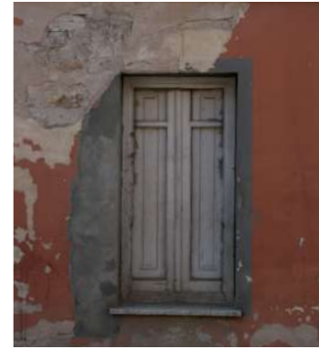
finestra senza stipiti con piattabanda in conci lapidei squadrati e serramento a due ante vetrate protette da scurini lignei interni
