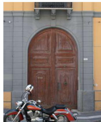
portone di palazzetto con arco a tutto sesto inserito su muratura intonacata bugnata
