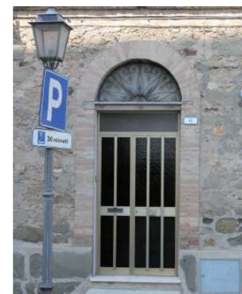
porta a due ante con arco a tutto sesto e stipiti in mattoni laterizi a due teste e sopralluce vetrato
