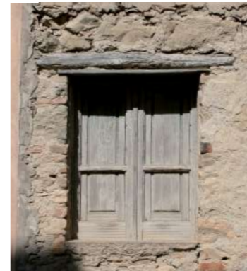
finestra senza stipiti con architrave ligneo che sovrastrano un tavolato di finitura; il serramento è a due ante vetrate protette da scuri interni
