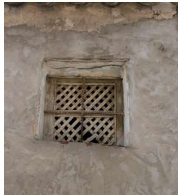
finestra senza stipiti con architravi lignei che sovrastrano un tavolato di finitura e serramento senza vetro con anta a graticcio
