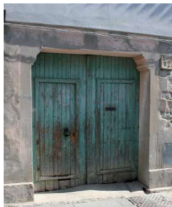
portale con architrave in cls armato e serramento ligneo inserito nella facciata dell'edificio
