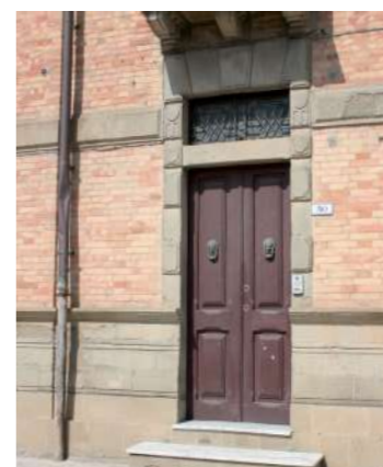
porta di palazzetto con piattabanda a cinque conci e stipiti in pietra squadrate e modanate
