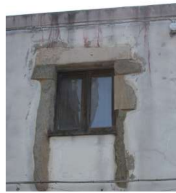
finestra rimaneggiata con architrave e stipiti lapidei
