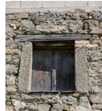
finestra con stipiti lapidei e architravi lignei squadrati giustapposti con serramento a due ante cieche
