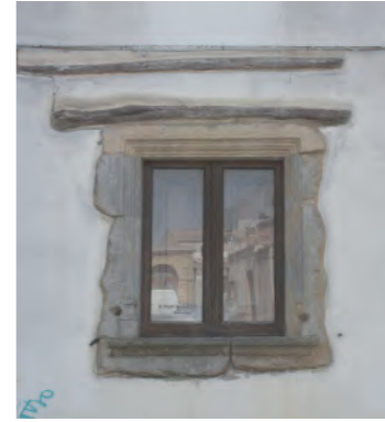
finestra con cornice omogenea lapidea squadrata e modanata sovrastrata da architravi lignei di scarico
