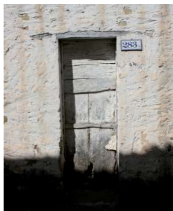
porta arcaica senza stipiti con serramento ad un'anta in tavolato esterno e traversi interni
