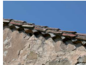
coronamento semplice su aggetto di tegole convesse parzialmente incassate nella muratura
