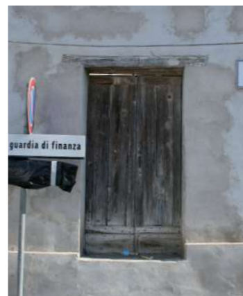
porta senza stipiti con serramento a doghe verticali esterne
