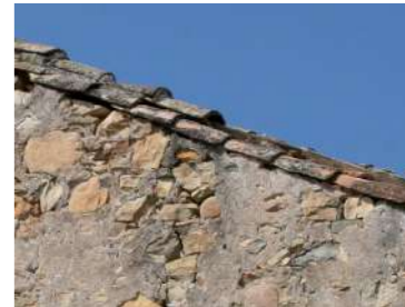
coronamento con doppia fila di tegole convesse, disposte a filo muro o livemente sporgenti
