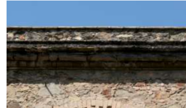
aggetto con cornice intonacata modanata realizzata in mattoni laterizi e muretto d'attico che nasconde il canale di gronda incassato
