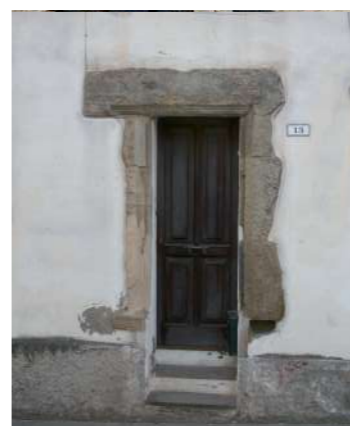
porta con stipiti e architrave lapidei squadrate e modanate con serramento a due ante cieche
