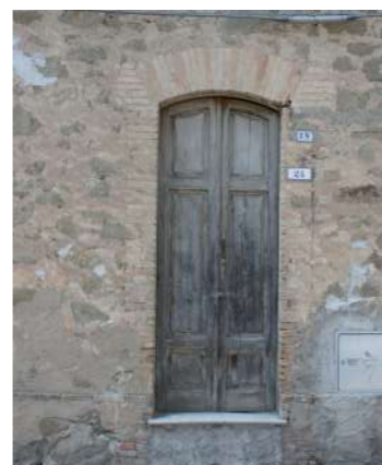
porta a due ante di palazzetto con arco ribassato e stipiti in mattoni laterizi
