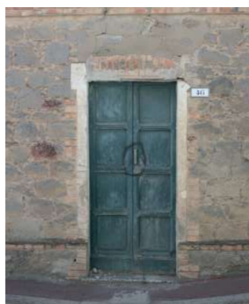
porta a due ante con piattabanda in mattoni laterizi a due teste e stipiti regolarizzati in laterizio
