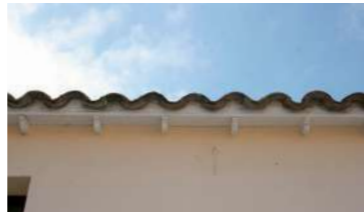
aggetto semplice della prima fila di coppi da tavolo su travicelli lignei aggettanti
