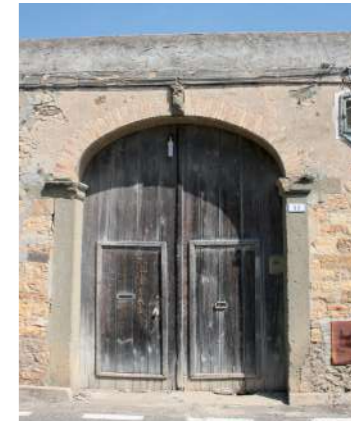
portale con arco a tre centri in mattoni laterizi a due teste su stipiti monolitici in pietra squadrata
