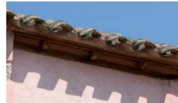
aggetto semplice della prima fila di coppi da tavolo su travicelli lignei aggettanti
