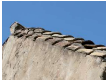
coronamento con doppia fila di tegole convesse, disposte a filo muro o livemente sporgenti
