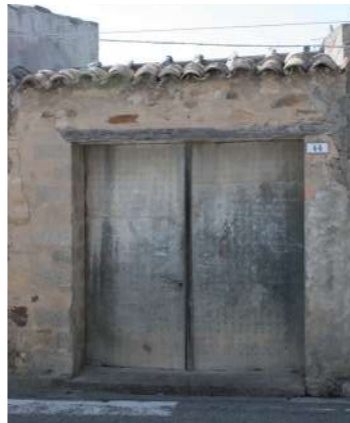
portale con serramento ligneo rivestito esternamente in lamiera metallica posto in vano proprio
