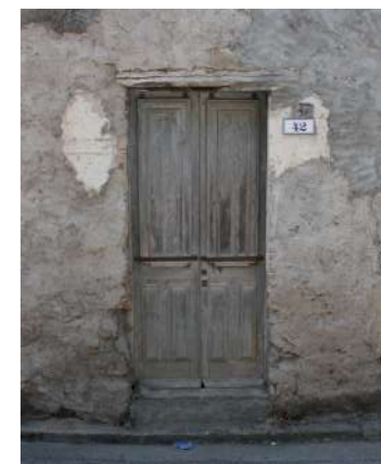
porta senza stipiti a vetri protetti da scurini estraibili esterni
