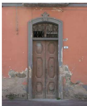
porta a due ante di palazzetto con arco ribassato e stipiti in mattoni laterizi e sopralluce vetrato
