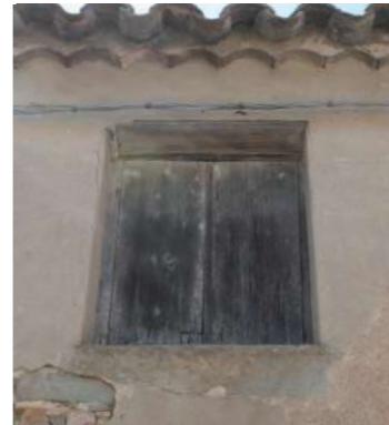
finestra senza stipiti con architravi lignei che sovrastrano un tavolato di finitura; il serramento ha due ante cieche realizzate in tavole verticali
