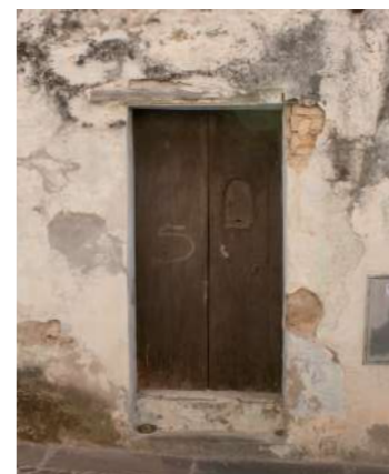
porta senza stipiti con serramento a due ante più antina apribile sull'anta destra
