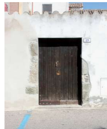
piccolo portone architravato con stipiti in pietra per l'accesso alla corte
