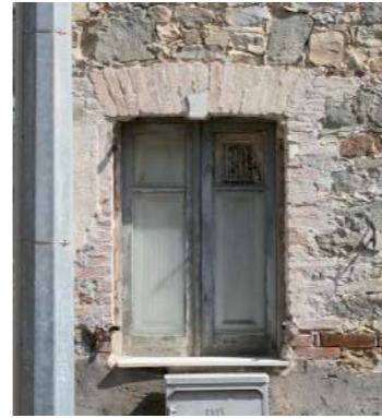
finestra con piattabanda in mattoni laterizi a due teste e stipiti rifiniti in laterizio con serramento a due ante vetrate protette da scurini lignei interni
