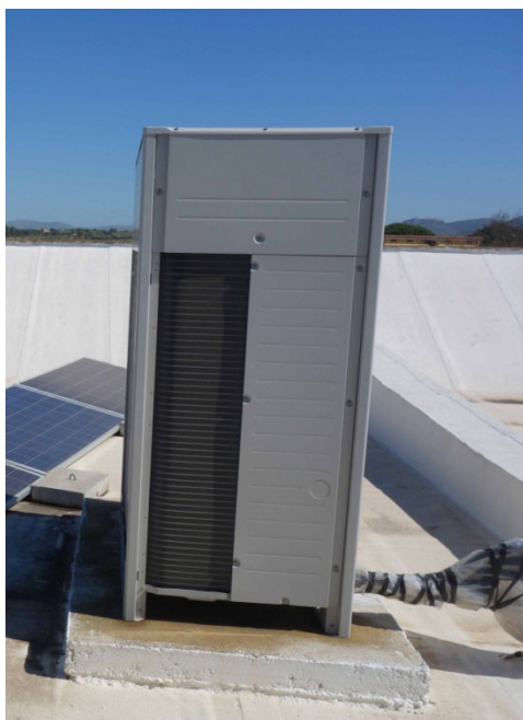
Figura 16. Unità esterna installata sulla copertura del blocco servizi e unità interna a cassetta
